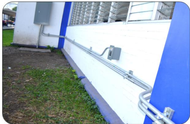
Fotos 31: Instalación del Centros de Carga y Pastillas Térmicas Proyecto de Climatización de Aulas de Clases de los Edificios 1 y 2
