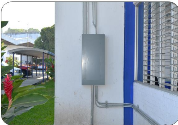
Fotos 31: Instalación del Centros de Carga y Pastillas Térmicas Proyecto de Climatización de Aulas de Clases de los Edificios 1 y 2
