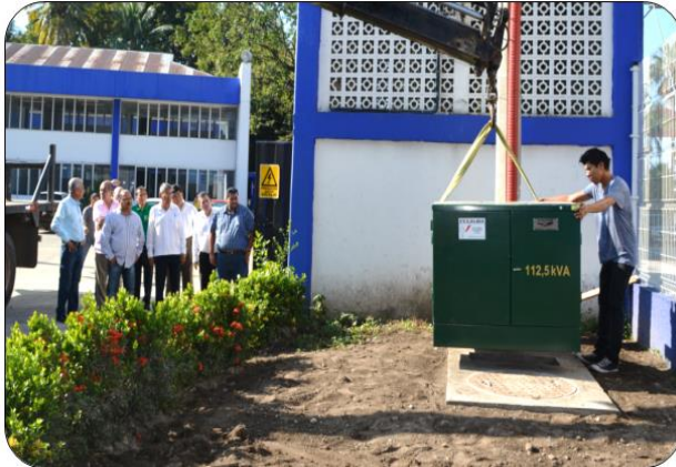
Fotos 30: Instalación del transformador de 112.5KVA Proyecto de Climatización de Aulas de Clases de los Edificios 1 y 2
